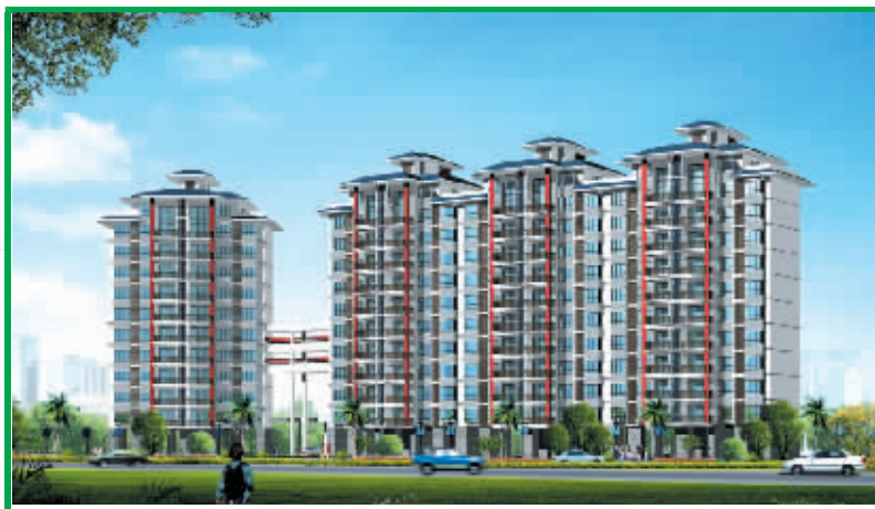
适用层数: 10~12层 宜户型面积: 90~110m 2 供水方式: 阳台分户供水 集热方式: 分散式 集热面积: 3.33m 2 /户
