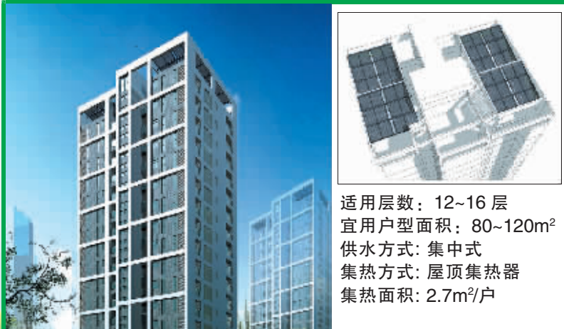
适用层数: 12~16层 宜户型面积: 80~120m 2 供水方式: 集中式 集热方式: 屋顶集热器 集热面积: 2.7m 2 /户
