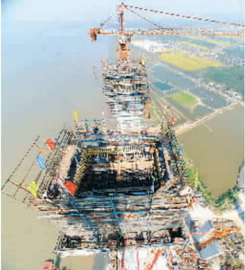
10月15日，总高180米的江苏泰州长江大桥北塔进入封顶施工。泰州长江大桥项目全长62.088公里。 新华社发
