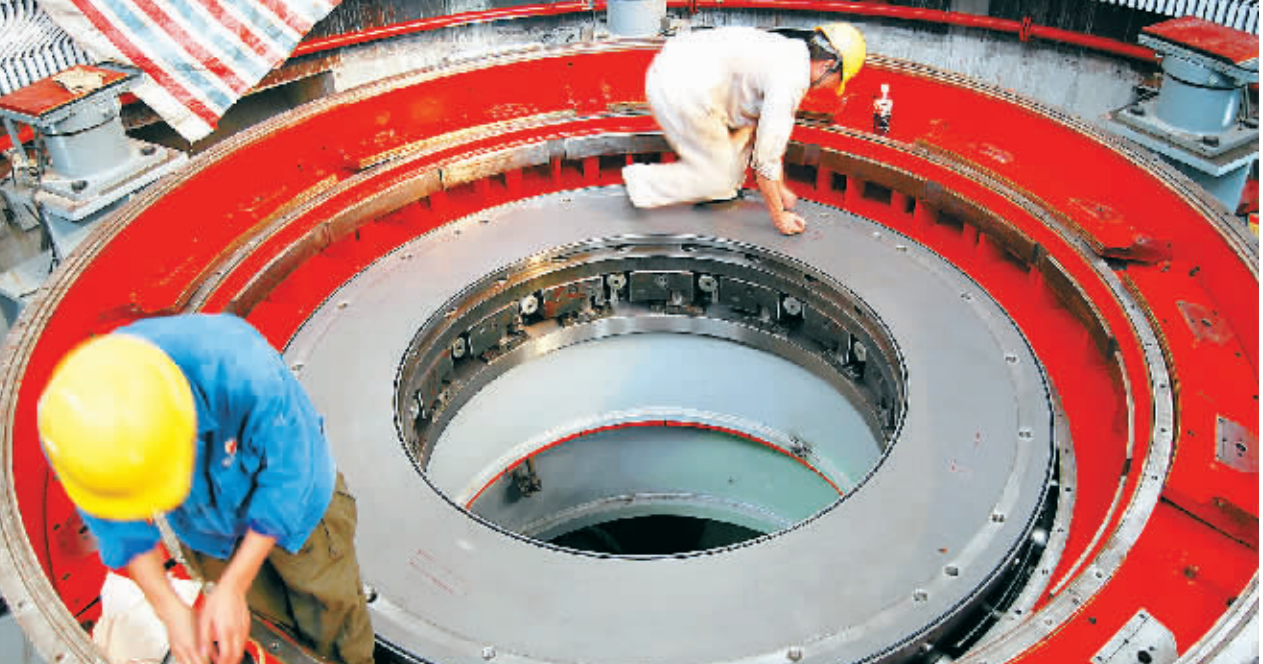
10月30日,戈枕枢纽——大广坝二期工程进入收尾阶段,目前已实现水库蓄水、第一台水力发电机实现并网发电,比实际设计工期提前9个月。戈枕枢纽大坝全长1092米,水库正常蓄水位54米,相应库容1.04亿立方米,将有效缓解东方、昌江两市县缺水问题。预计全部工程年底完工投入使用。图为工程技术人员在安装2号机组。 本报记者苏晓杰 通讯员关颂平 摄
