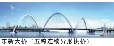
东新大桥（五跨连续异形拱桥）
