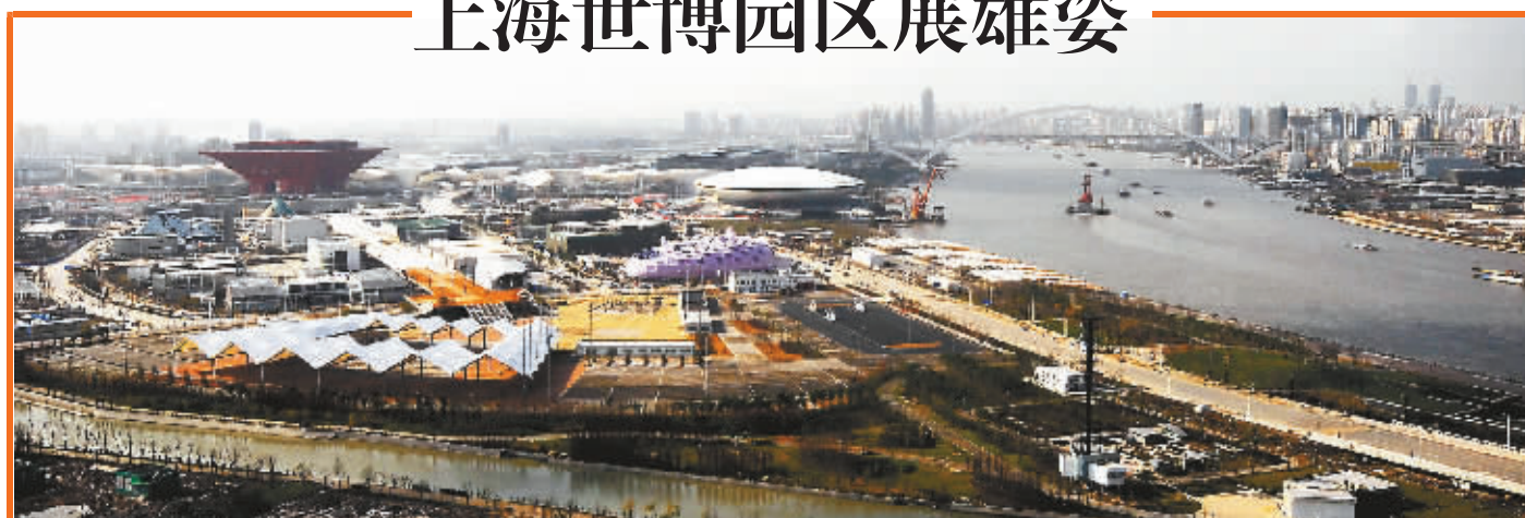
12月14日拍摄的建设中的上海世博会浦东园区。随着上海世博会日益临近,黄浦江两岸的世博园区场馆展露雄姿。新华社发
