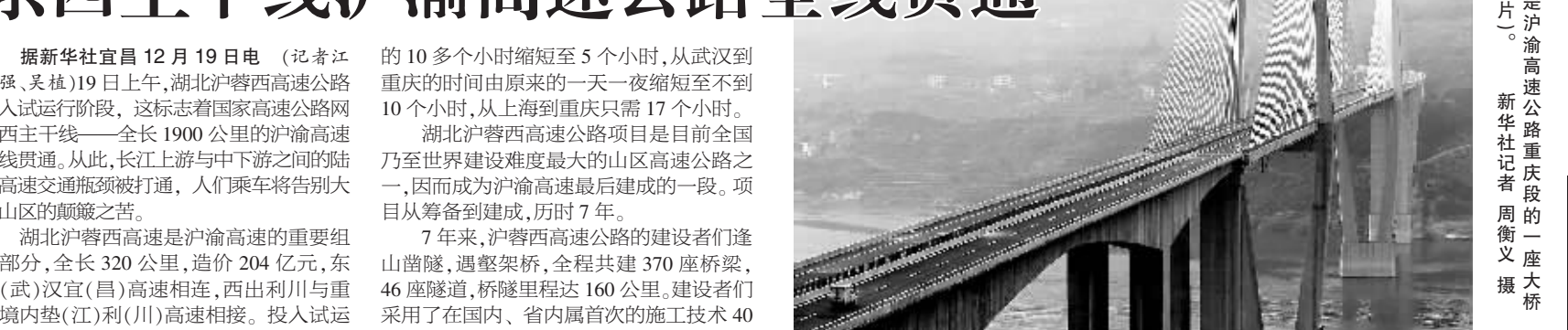
这是沪渝高速公路重庆段的一座大桥(资料照片)。新华社记者周衡义摄
