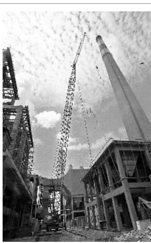
1980年代，建设中的马村电厂。 本报资料图片
