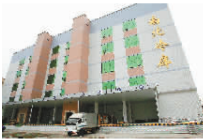
南北冷冻保鲜物流冷库外观。
