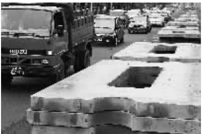
无砟轨道板侵占车道,且没有设置警示标志。
