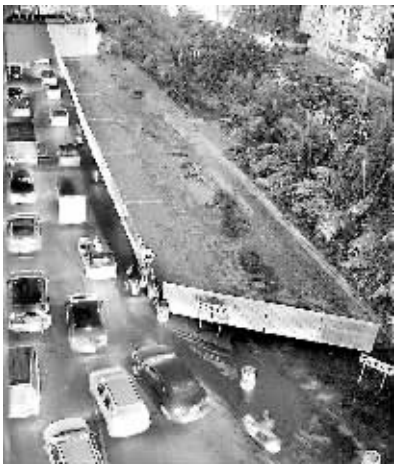
被围住的大半路面空空荡荡没有施工,而另一边路面上车辆却排起长龙。 本文照片均由本报记者 古月 摄
