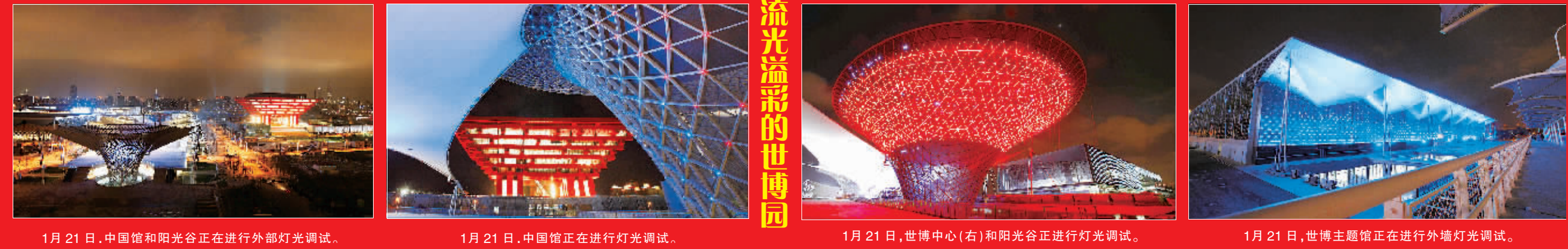
1月21日,中国馆和阳光谷正在进行外部灯光调试。 1月21日,中国馆正在进行灯光调试。 1月21日,世博中心(右)和阳光谷正进行灯光调试。 1月21日,世博主题馆正在进行外墙灯光调试。
