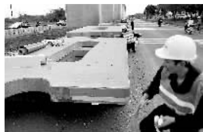
上图：22日下午，南海大道汽车南站瓶颈路口拥堵不堪。右下图：几名工人正在往无砟轨道板上粘贴反光警示条。
