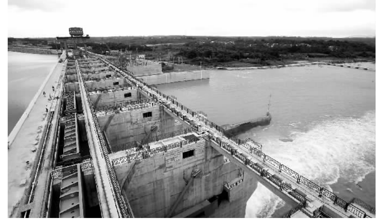
戈枕水利枢纽工程。 本报记者 苏晓杰 摄
