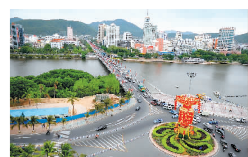
3月9日,三亚河上的新风桥车流不息。由于桥面太窄、交通不畅,横跨三亚河的新风桥将重建。
