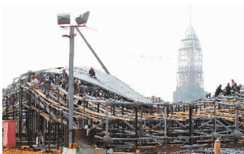
在海南国际会展中心工地，工人们正在安装钢结构屋顶。 本报记者 苏晓杰 摄
