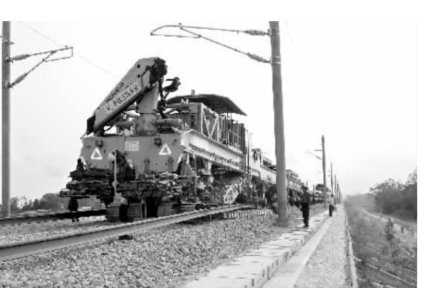
↑ 三亚至陵水段铁路正在铺设中。
