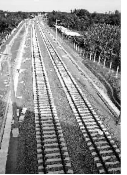
海南东环铁路文昌段正在铺设中。
