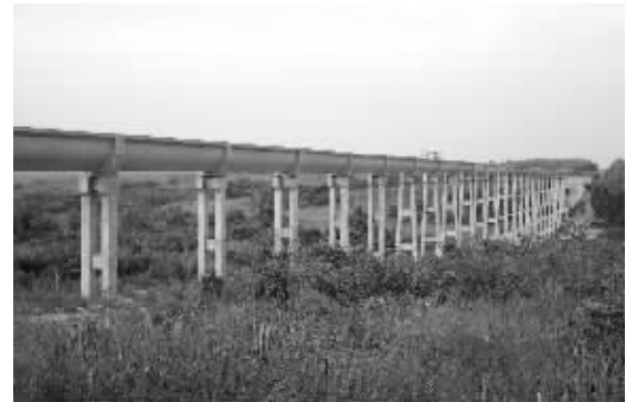
省水电集团公司承建的大广坝水利水电二期(灌区)工程目前已完成投资7.1亿元,占工程总投资的52.6%。(图为红泉分干4#渡槽,全长600米)
