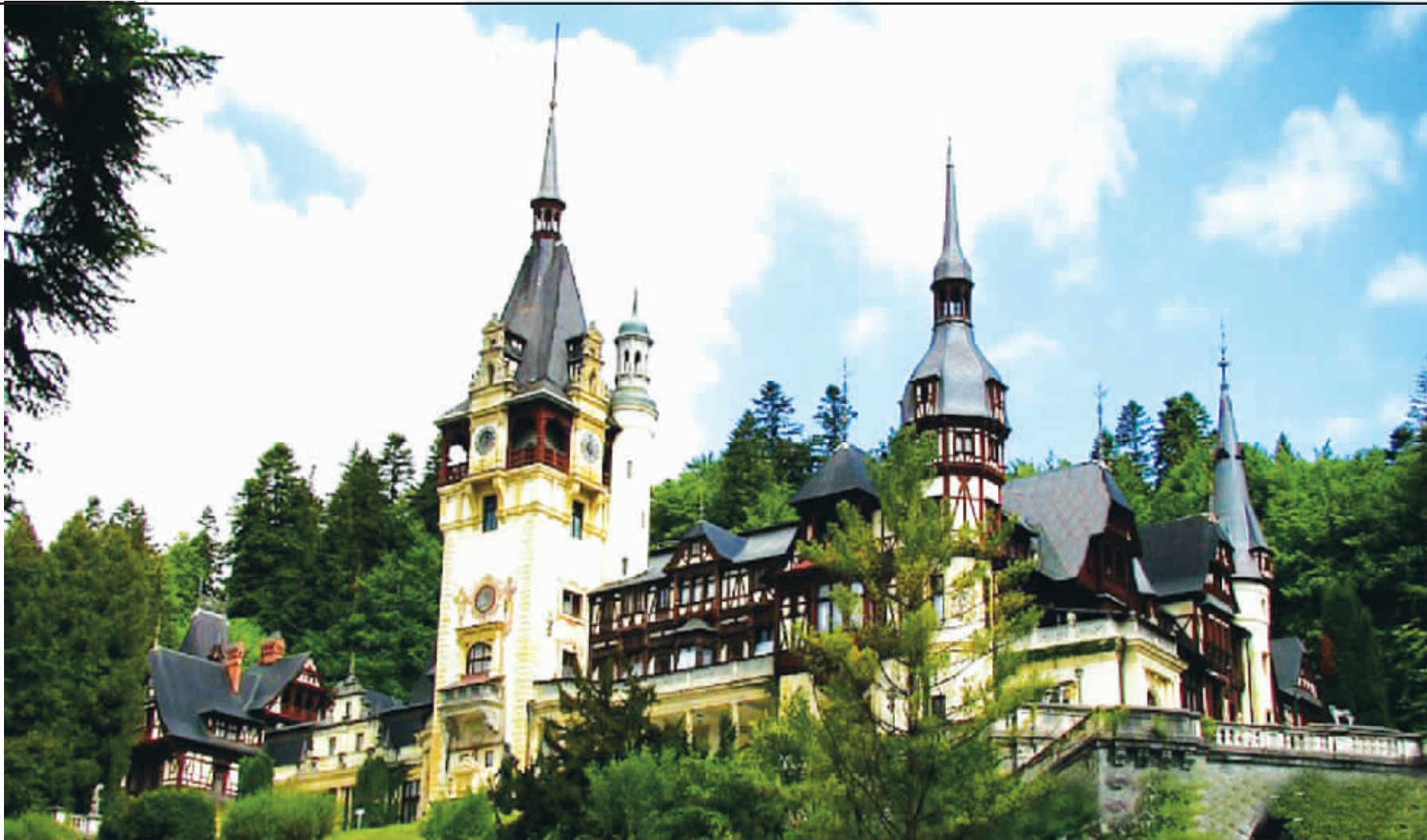
图片说明：庄严华丽的佩什什王宫位于罗马尼亚境内，是1873年罗马尼亚卡罗尔国王请来德国建筑师设计建造的一幢哥特式建筑杰作。三个塔尖直插云霄，高高的花窗、直立的扶壁，宫殿内部富丽堂皇，陈设幽雅，宫殿前面光彩夺目的大理石平台上有水池和千姿百态的石雕，体现了文艺复兴时期不朽的哥特式建筑风格。
