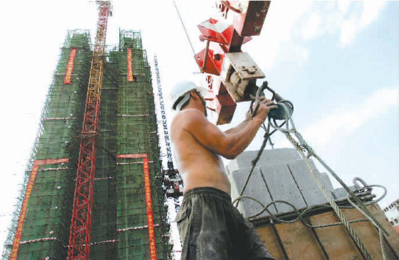
目前海口各个廉租房小区建设进展顺利，部分小区楼房已封顶。图为5月17日在海口市琼山区博雅小区廉租住房建设项目现场，工人在已经顺利封顶的大楼外面进行外装修施工。
