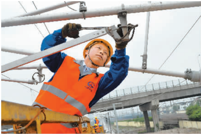
这是巨晓林在铁路接触网施工作业（5月15日摄）。 新华社发
