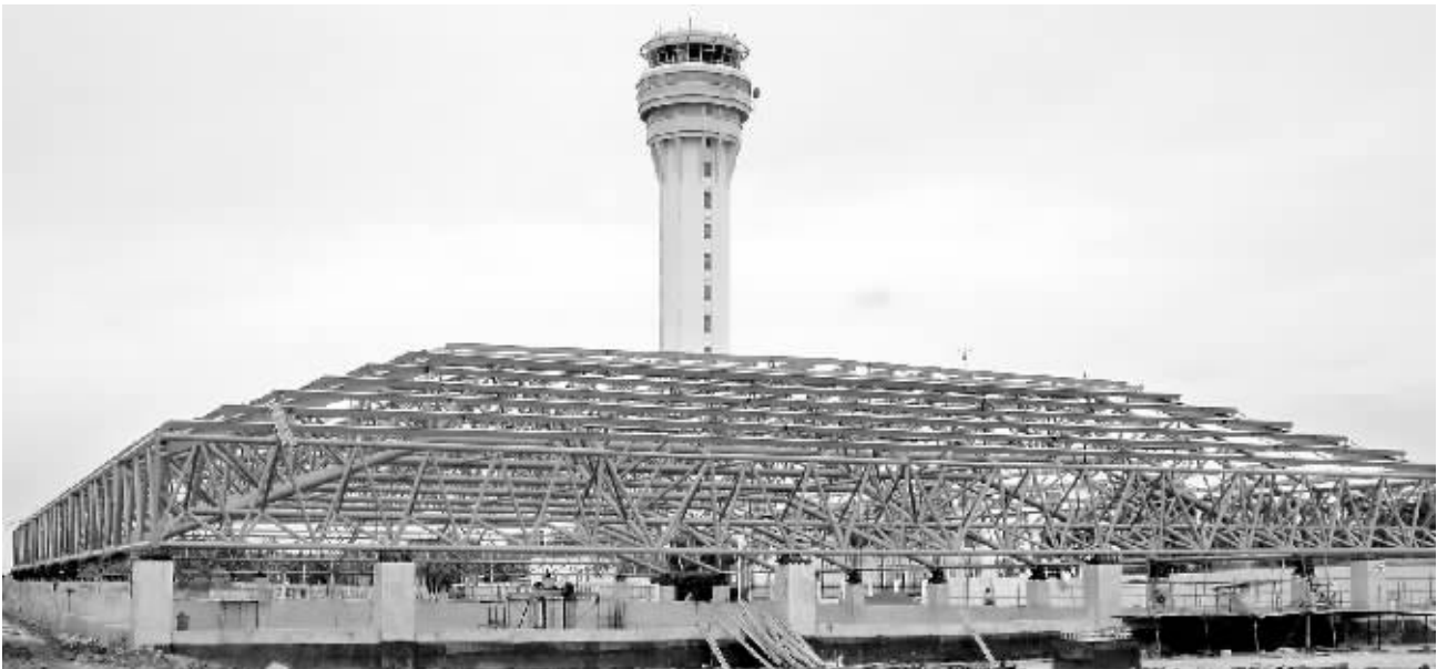
东环铁路美兰站候车大厅主体建成 6 月 29 日,国内首个高速铁路与飞机场无缝连接站——东环铁路美兰站站房建成。据了解,东环铁路美兰机场站设在机场候机楼附近的地下,乘客通过地下通道可直接从机场候机大厅到达火车站候车大厅。 本报记者 古月 摄
