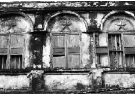
文昌铺前镇骑楼窗户造型纹饰多样。海南日报记者 李幸璜 摄
