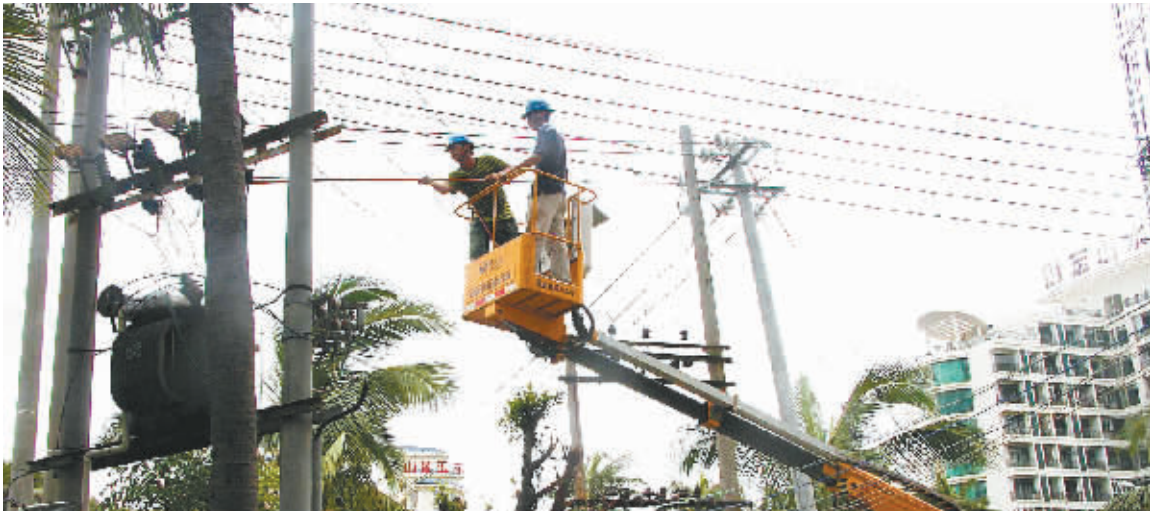
7 月 17 日,三亚供电公司工人在紧急抢修台风中受损的电力设施。 新华社发 (李柳清 摄)
