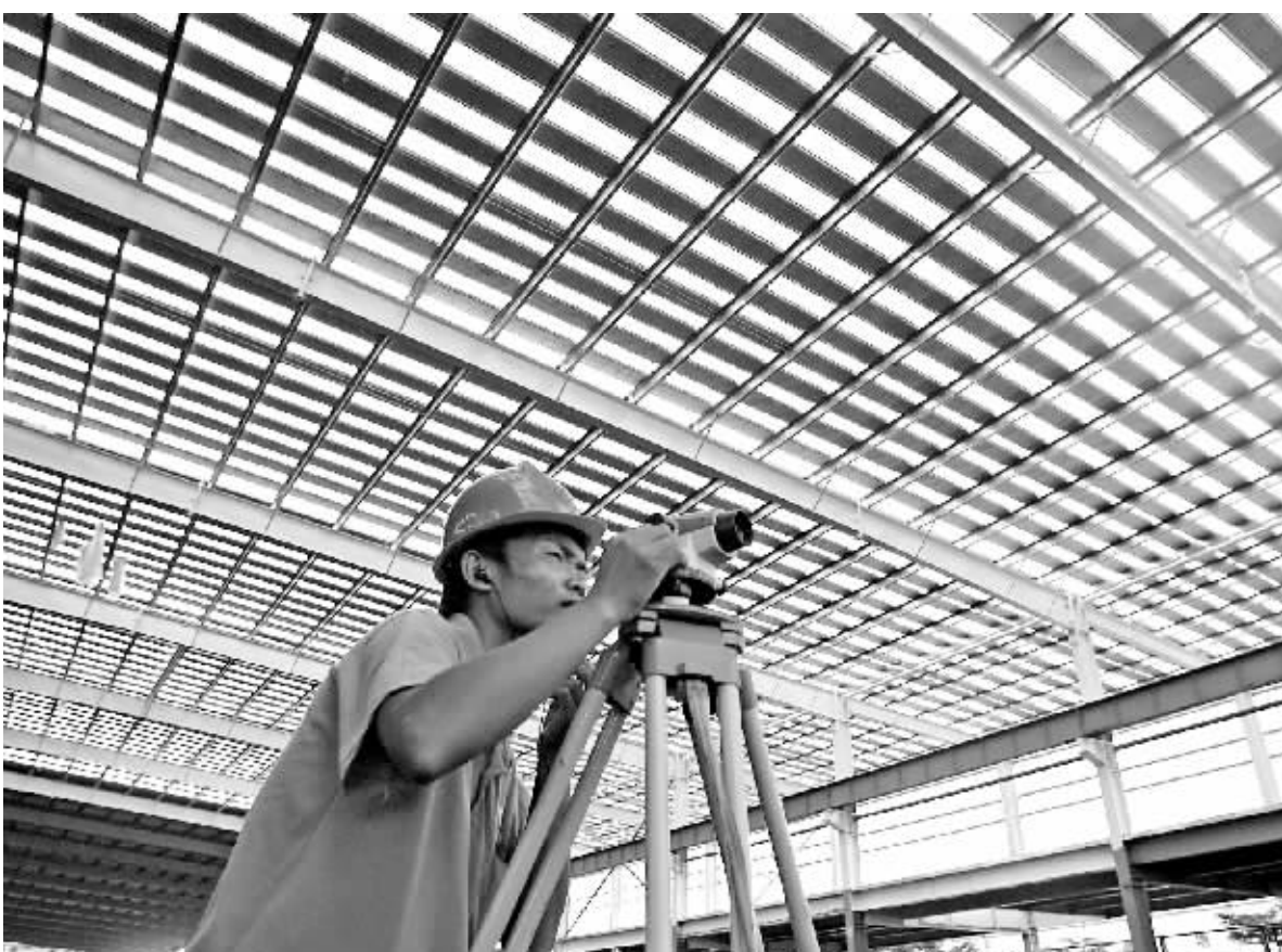
七月二十七日,海南老城经济开发区,海南中航特玻材料有限公司正在加紧建设深加工厂房,建成后将为该厂2号生产线生产超白太阳能TCO玻璃。本报记者 李英挺 实习生 李健 摄
