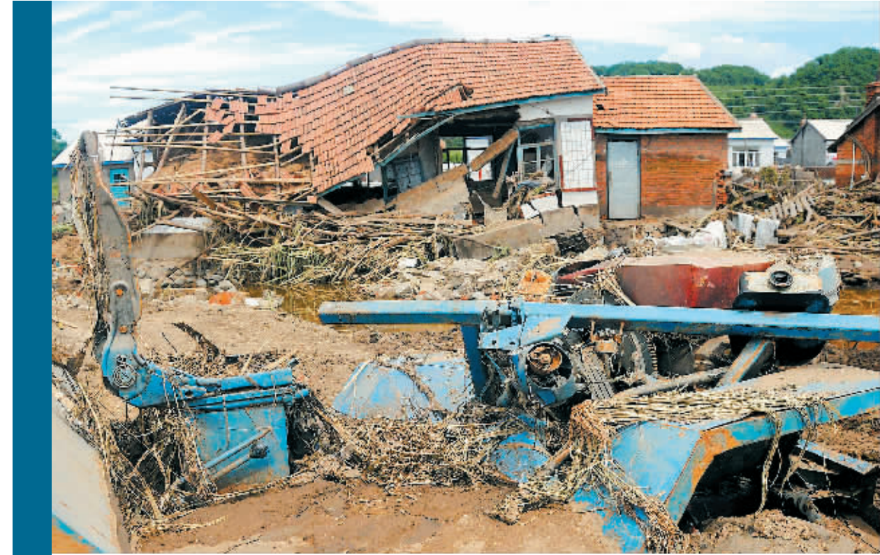
这是吉林省桦甸市二道甸子镇被洪水损毁的房屋(2010年8月2日摄)。
