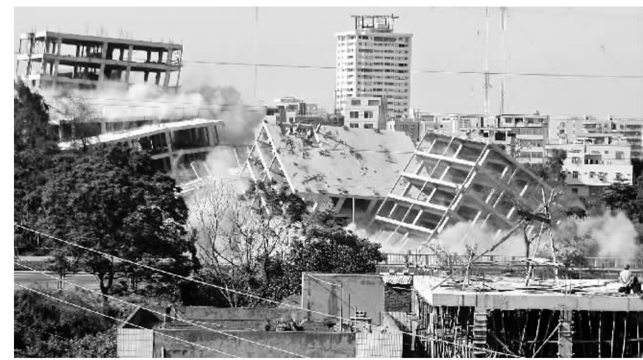
8月5日下午,紧邻海口美舍河大桥的13栋违章建筑瞬间夷为平地。为了打击违建,海口市市委、龙山区政府组织了此次对违法建筑的定向爆破拆除。本报记者 李英挺 实习生 李健 摄
