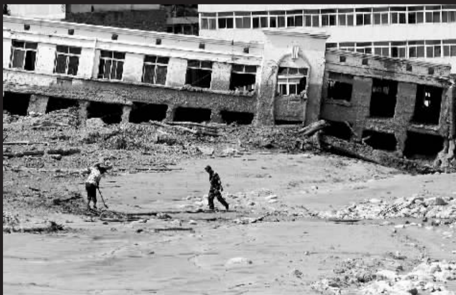
舟曲县城很多建筑被泥石流淹埋、损坏。
