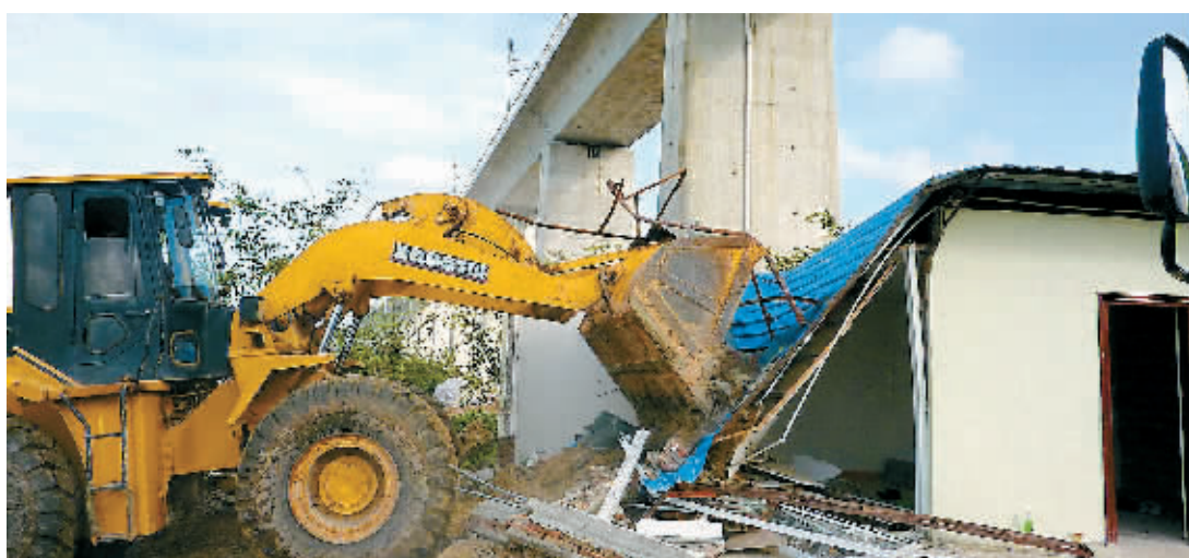
8月20日,三亚执法人员拆除东环铁路沿线的违法建筑。本报记者刘贡摄
