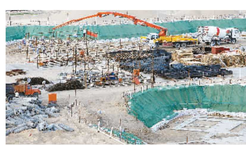
国信龙沐湾项目工地现场 宋国强摄
