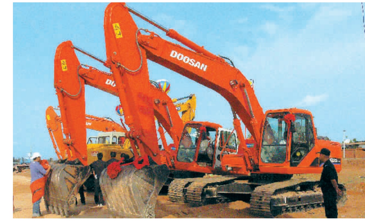
龙沐湾国际旅游度假区施工现场。
