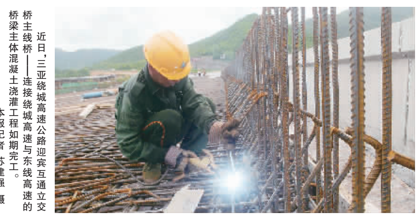
近日,三亚绕城高速公路迎宾互通立交桥梁主体工程混凝土浇筑工程如期完工。本报记者 苏建强 摄
