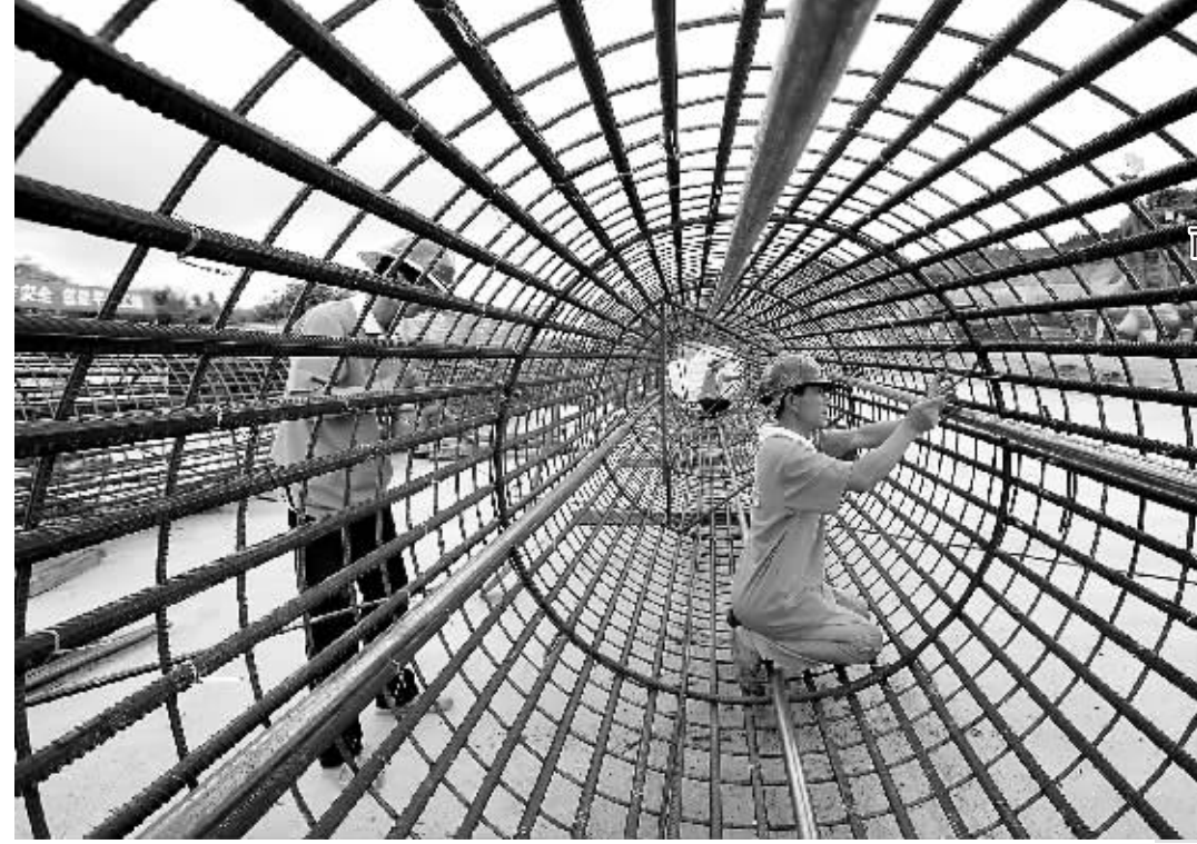
海屯高速南渡江特大桥加紧建设
