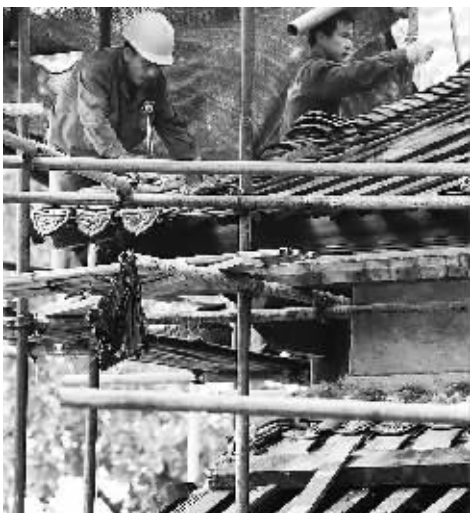
➡ 图为工人正在重建东坡书院载酒亭。 柯人俊 摄
