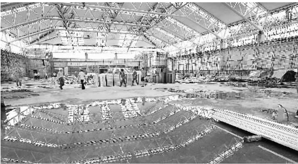
25日下午,工人们正在东铁路美兰机场火车站地下候车大厅紧张施工。东铁路海口美兰机场火车站主体已完工。候车大厅、站台、连接机场通道等内部装修全面展开,设备安装同步进行,11月底将全部建成交付使用。 本报记者 古月 摄
