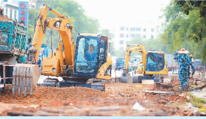
9月26日,全长2公里的风凰路改造工程开工,预计春节前竣工。本报记者 苏建强 摄
