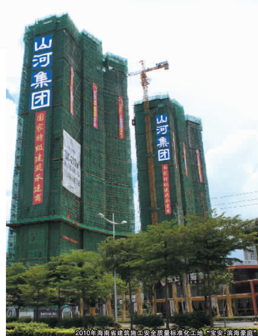
2010年海南省建筑施工安全质量标准化工地“宝安·滨海豪庭”
