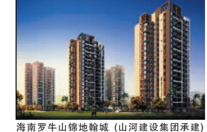
海南罗牛山锦地翰城（山河建设集团承建）
