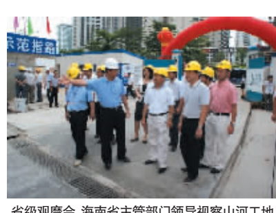
省级观摩会，海南省主管部门领导视察山河工地
