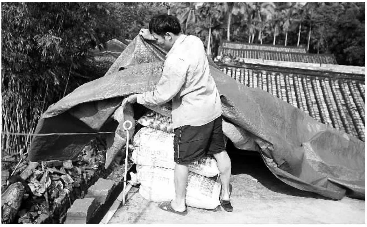
10月20日,为防台风侵袭,琼海市塔洋镇联先村委会加浪村村民王甲坤,将稻谷扛上房顶堆放。
