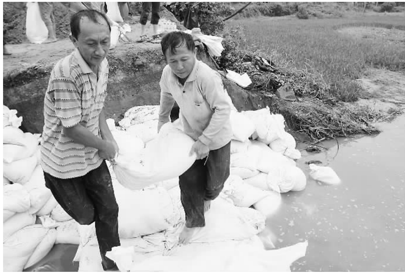
10月18日,文昌市交通管理部门正在组织抢修文城镇通往东楼村被冲毁的路桥。
