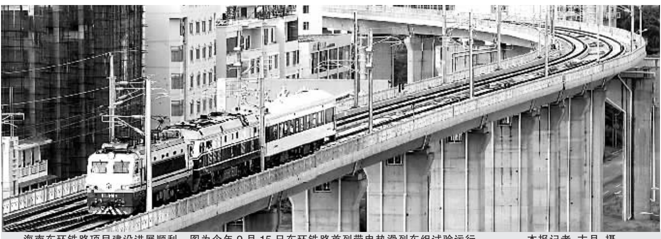
海南东环铁路项目建设进展顺利。图为今年9月15日东环铁路首列带电滑列车组试验运行。 本报记者 古月 摄
