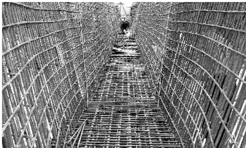
工人正在绑扎大桥的箱梁钢筋。 本报记者 宋国强 特约记者 许环峰 摄
