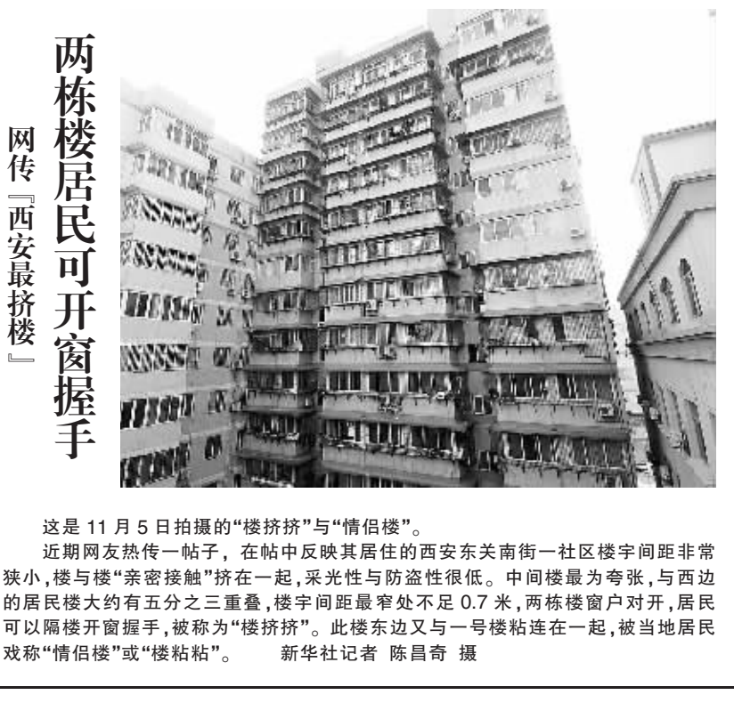
这是11月5日拍摄的“楼挤楼”与“情侣楼”。近期网友热传一帖子,在帖中反映其居住的西安东关南街一社区楼宇间距非常狭小,楼与楼“亲密接触”挤在一起,采光性与防盗性很低。中间楼最为夸张,与西边的居民楼大约有五分之三重叠,楼宇间距最窄处不足0.7米,两栋楼窗户对开,居民可以隔楼开窗握手,被称为“楼挤楼”。此楼东边又与一号楼粘连在一起,被当地居民戏称“情侣楼”或“楼粘楼”。
