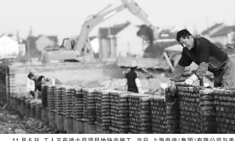
11月5日,工人正在迪士尼项目地块内施工。当日,上海申迪(集团)有限公司与美国华特·迪士尼公司在上海签署上海迪士尼乐园项目合作协议,标志着上海迪士尼乐园项目正式启动。
