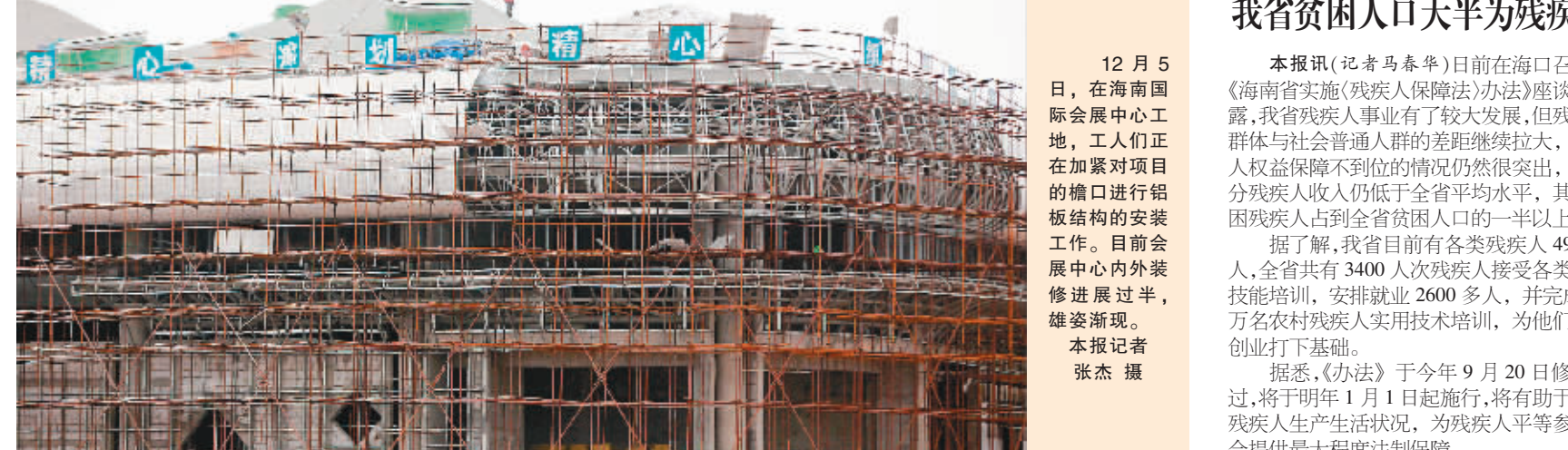
12月5日,在海南国际会展中心工地,工人们正在加紧对项目的檐口进行铝模板结构的安装工作。目前会展中心内外装修进展过半,雄姿渐现。本报记者 张杰 摄
