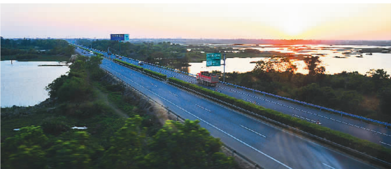
列车在晚霞中驶过东线高速公路海口段。
