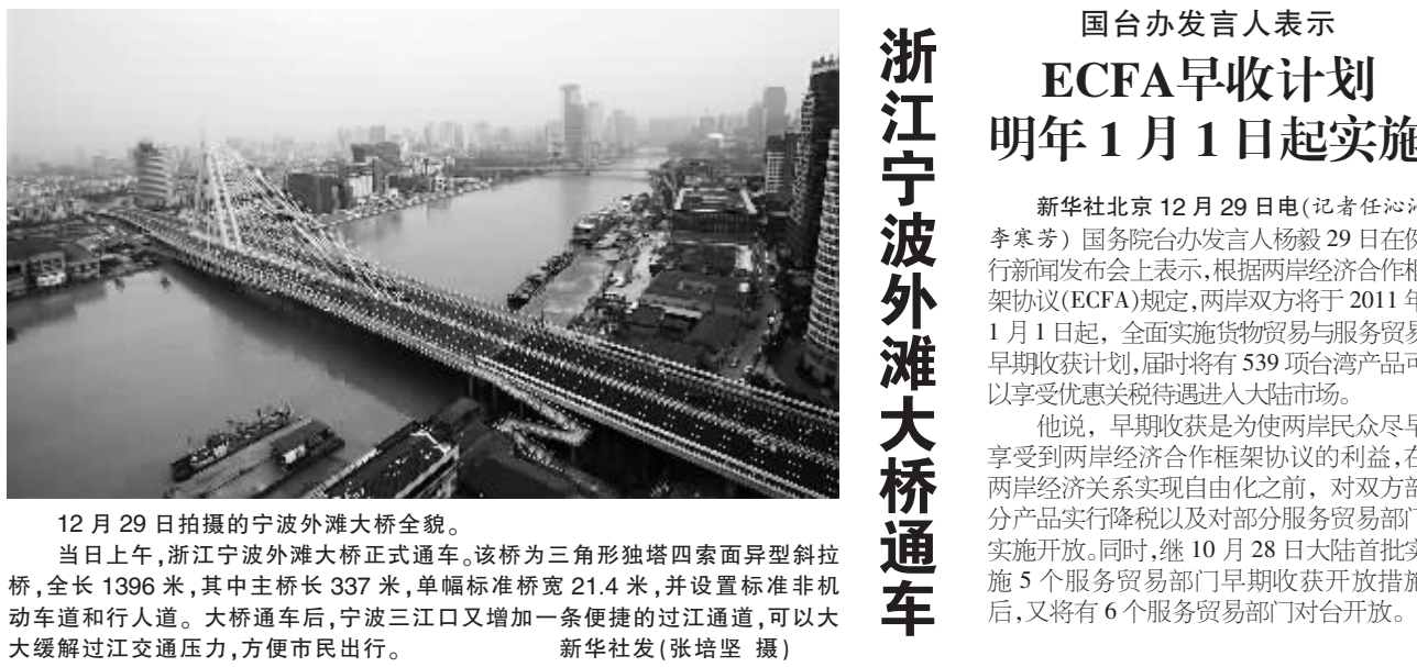
12月29日拍摄的宁波外滩大桥全貌。当日上午，浙江宁波外滩大桥正式通车。该桥为三角形塔四索面异型斜拉桥，全长1396米，其中主桥长337米，单幅标准桥宽21.4米，并设置标准非机动车道和行人道。大桥通车后，宁波三江口又增加一条便捷的过江通道，可以大大缓解过江交通压力，方便市民出行。新华社发(张培坚 摄)
