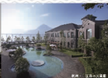
杭州·江湾公寓实景图
