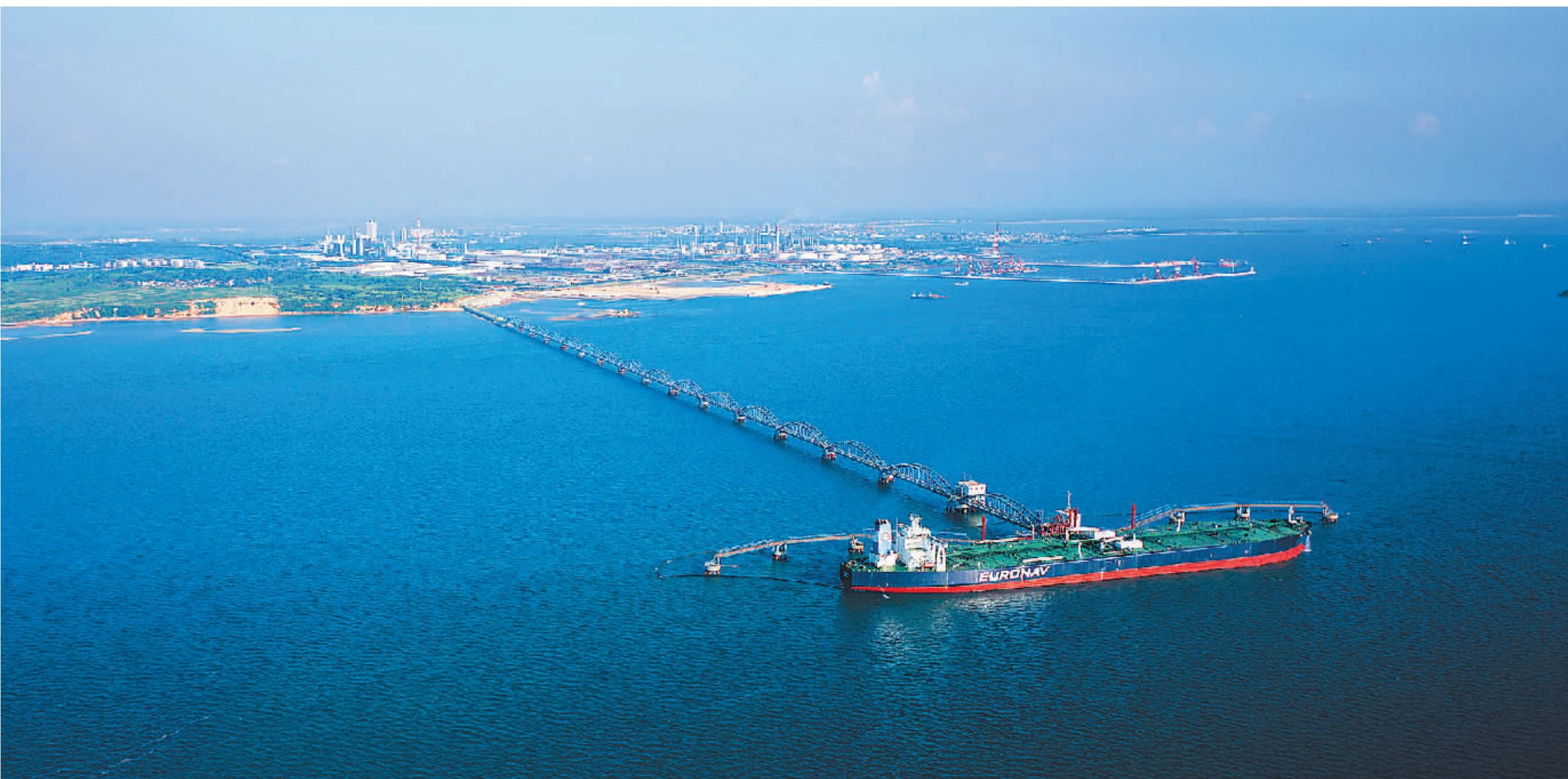
空中俯瞰洋浦原油码头。
