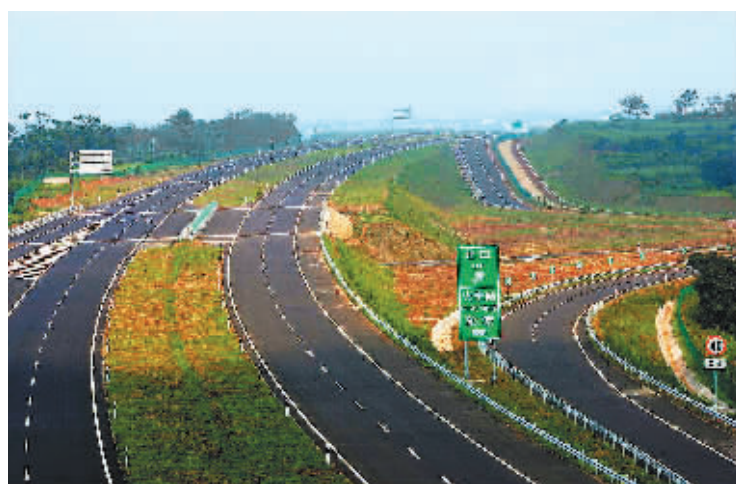
海口绕城高速公路疏港大道出口段。 本报记者 张杰 摄
