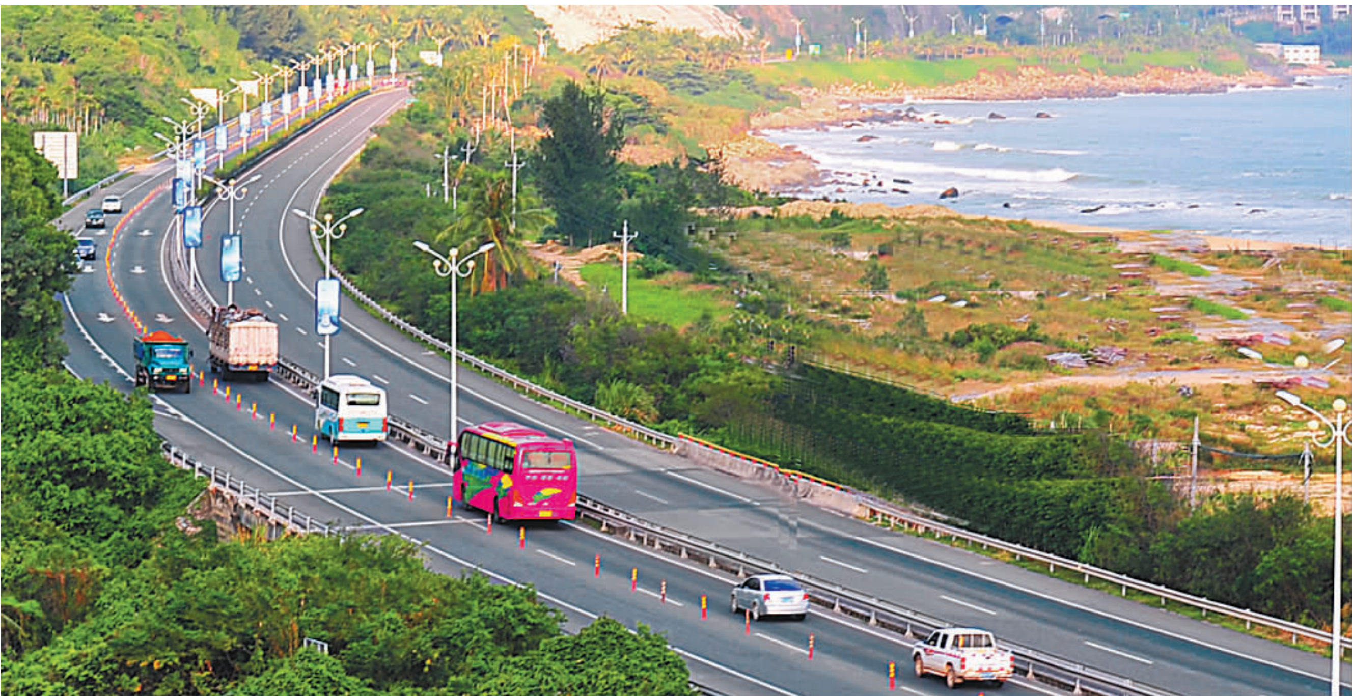
东线高速公路陵水分界洲牛岭段犹如一幅风景画。 本报记者 古月 摄
