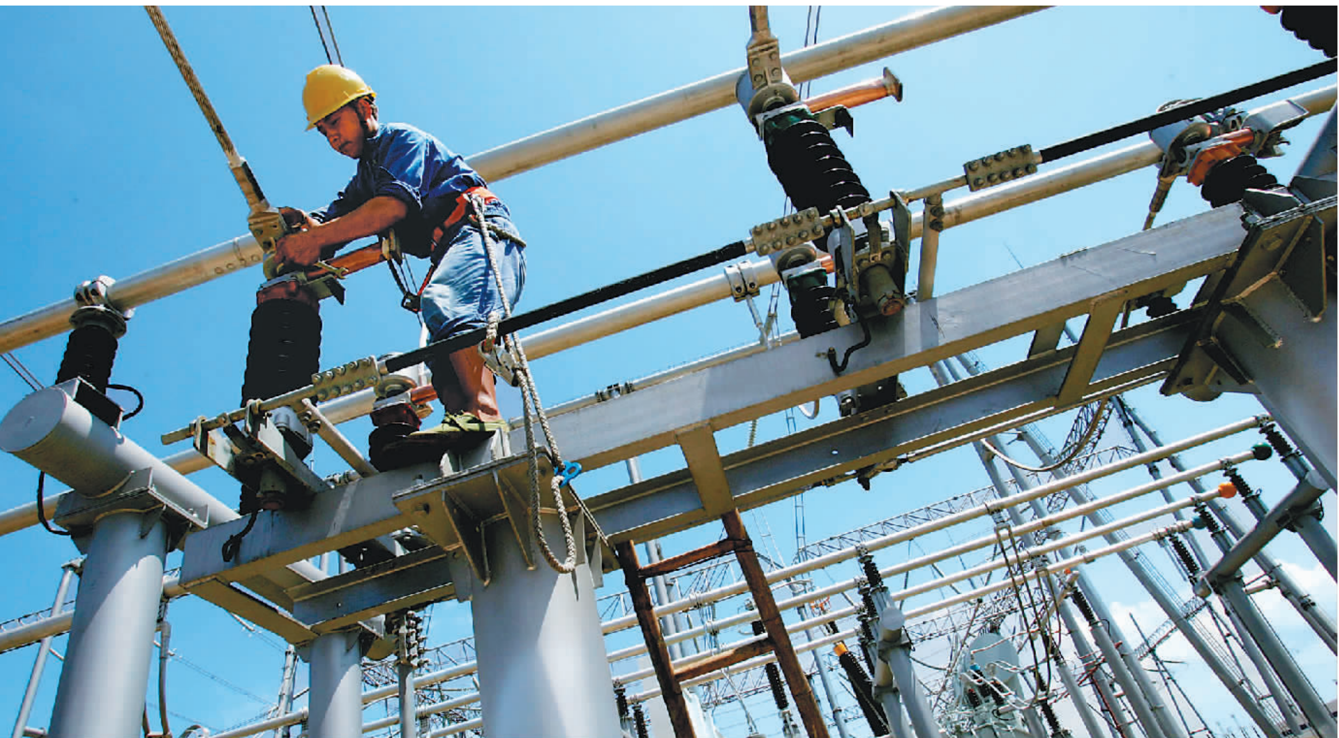
500千伏跨海联网工程,结束海南电力孤岛运行历史。
