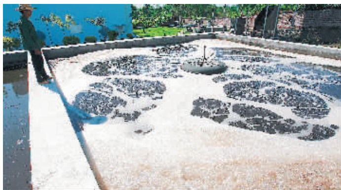
海口市城西镇巷东村的海口苍隆五万头猪场的这座沼气站配有1200立方米容量的大型沼气发酵池,每天可产沼气800立方米左右。
