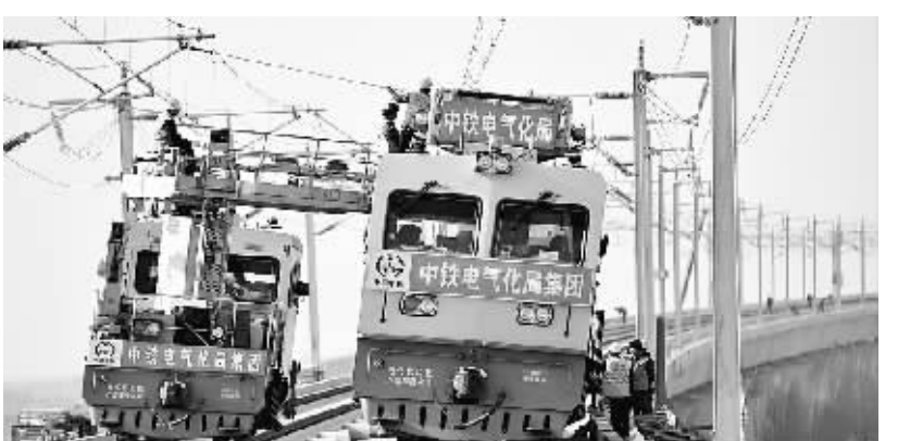
3月4日,京沪高铁工程车辆在武清区豆张庄牵引站高架进行施工作业。奋战在京沪高速铁路天津段的国家电网天津电力建设者克服重重困难,适时优化调整施工方案,确保该工程能够圆满按时保质完工。据介绍,京沪高速铁路天津段新建电力设施和改造项目总投资超过5亿元,架设电缆线路总长达70余公里。 新华社发
