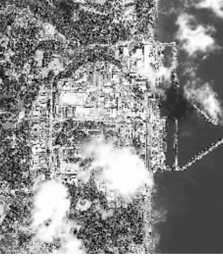
这张卫星图像显示的是 2011 年 3 月 12 日拍摄的福岛第一核电站。 福岛第一核电站和第二核电站运营商日本东京电力公司 13 日早晨通报政府, 第一核电站 3 号机组出现“紧急状态”, 但公司已经采取排气减压、灌注淡水等措施处理。日本内阁官房长官野田圣二 13 日警告说, 福岛第一核电站 3 号机组反应堆面临遭遇外部氢气爆炸风险, 但 3 号机组能够抵御住爆炸。 新华社/路透
